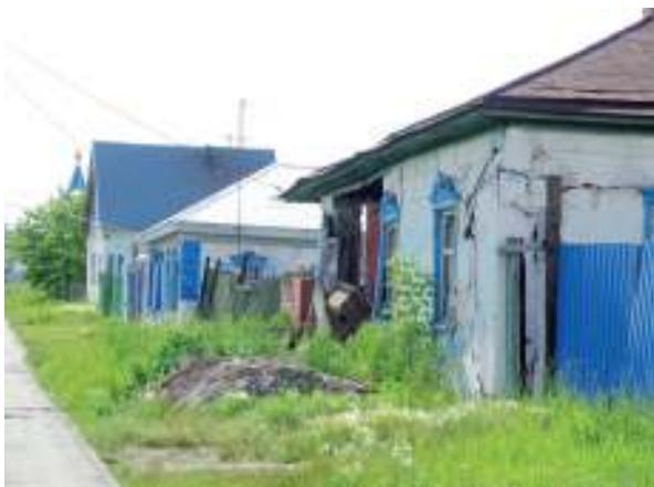
Рис. 2.29 Разрушение домов в зоне подтопления в г. Барабинске, Новосибирская область
