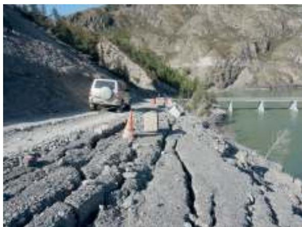
Рис. 2.26 Разрушаемый участок дороги в с. Инегень, Республика Алтай
