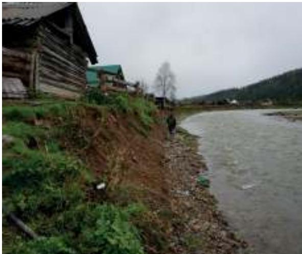
Рис. 2.32 Хозяйственные строения в зоне разрушения берегового уступа в с. Курмач-Байгол, Республика Алтай
