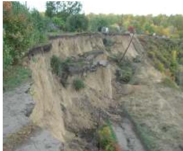
Рис. 2.33 Разрушение оползневыми процессами территории СНТ «Обь», г. Барнаул, Алтайский край
