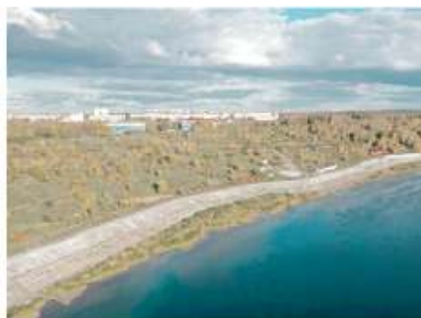
Рис. 81 Противооползневые сооружения на пункте наблюдений Лагерный сад в г. Томск, Томская область
