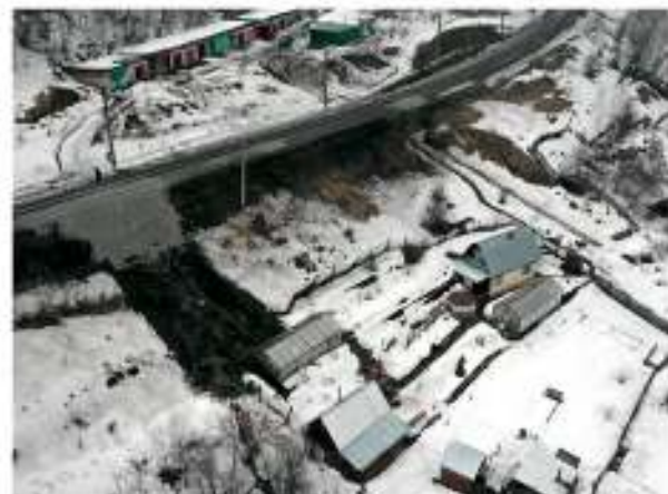
Рис. 84 Оползень в районе ул. Лесозащитная, г. Томск
