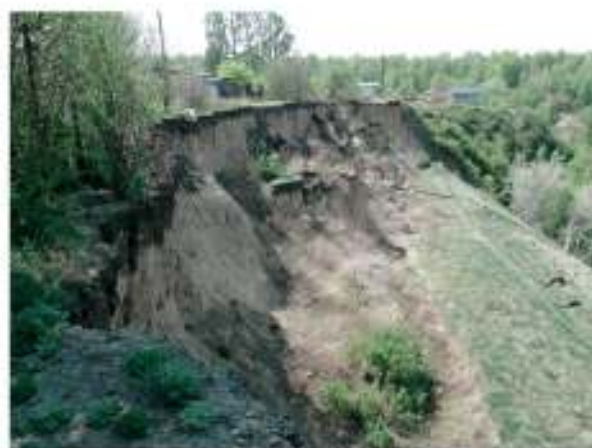
Рис. 61 Разрушение оползневой блока в СНТ «Обь», Четвёртый оползневой район, г. Барнаул, Алтайский край
