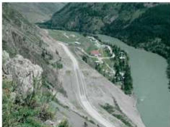
Рис. 55 Оползневые процессы на автодороге в Алтайское подворье (темный участок – отремонтированное асфальтовое покрытие)
