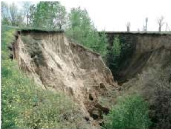
Рис. 64 Развивающийся овраг № 2 (район «Стройрегионгаза») на Тальменском пункте ГОНС, Алтайский край
