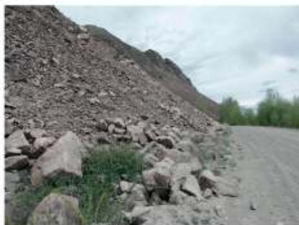
Рис. 60 Осыпи на участке автодороги Кызыл – Баян-Кол, 25 км, Кызылский район, Республика Тыва
