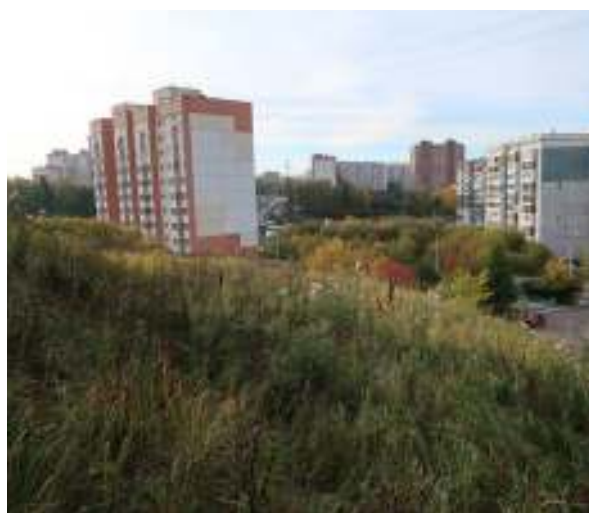
Рис. 171 Оползневые процессы на пункте наблюдений мкр Солнечный в г. Томске, Томская область
