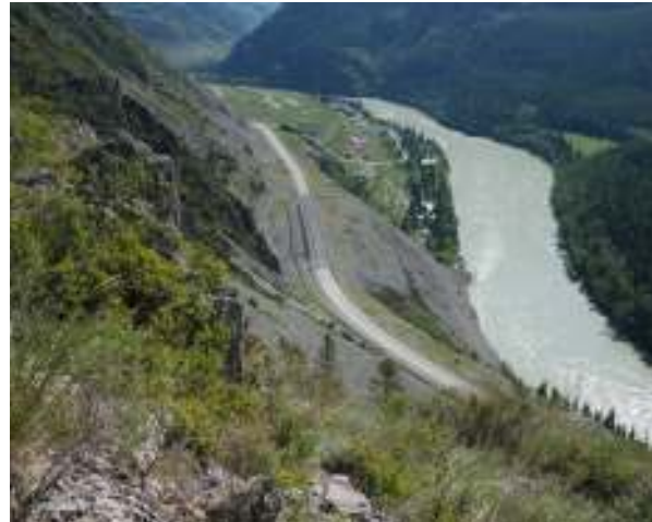
Рис. 135 Оползневые процессы на автодороге в Алтайское подворье (темный участок автодороги – отремонтированное асфальтовое покрытие)
