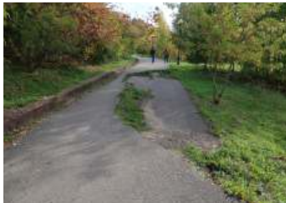
Рис. 170 Формирование оползня на пункте наблюдений Лагерный сад в г. Томске, Томская область
