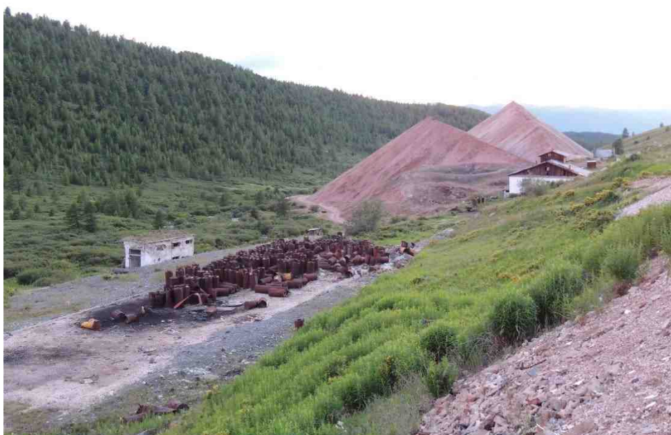
Рис. 1.55 Общий вид отвалов и остатков ртутного завода Акташского ГМП
