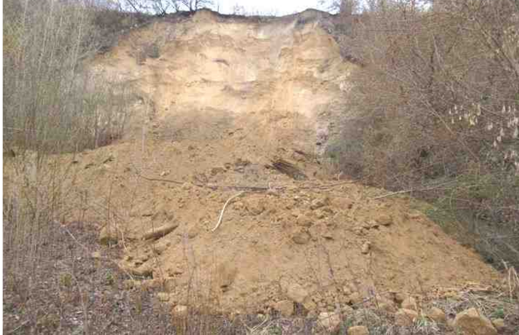
Рис. 2.21 Оползень во втором оползневом районе, г. Барнаул, Алтайский край
