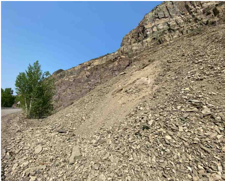
Рис. 2.20 Осыпи на участке автодороги Кызыл – Баян-Кол, 23 км, Кызылский район, Республика Тыва
