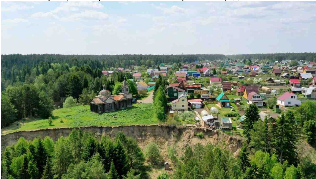
Рис. 2.48 Стенка отрыва оползня в д. Нагорный Иштан, Томская область
