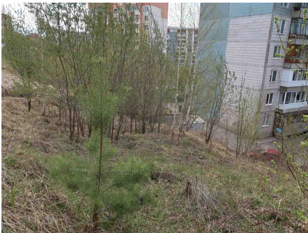
Рис. 2.47 Оползневые процессы на пункте наблюдений мкр Солнечный в г. Томске, Томская область
