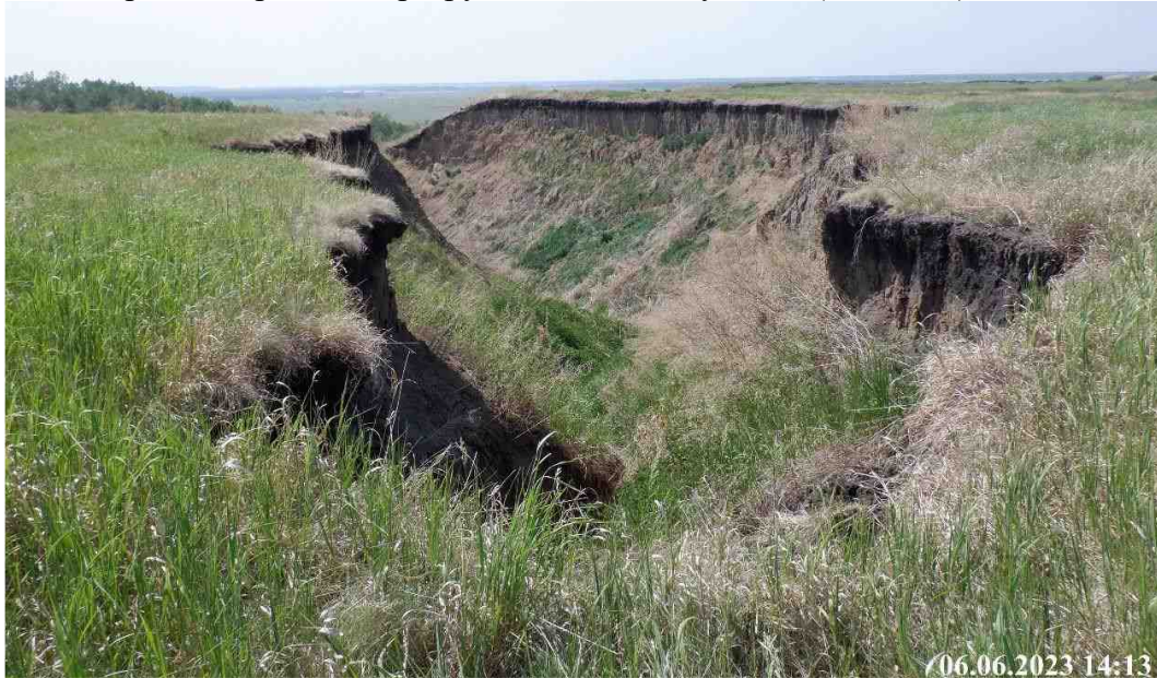
Рис. 2.41 Проявления овражной эрозии на Горьковском участке, Омская область
