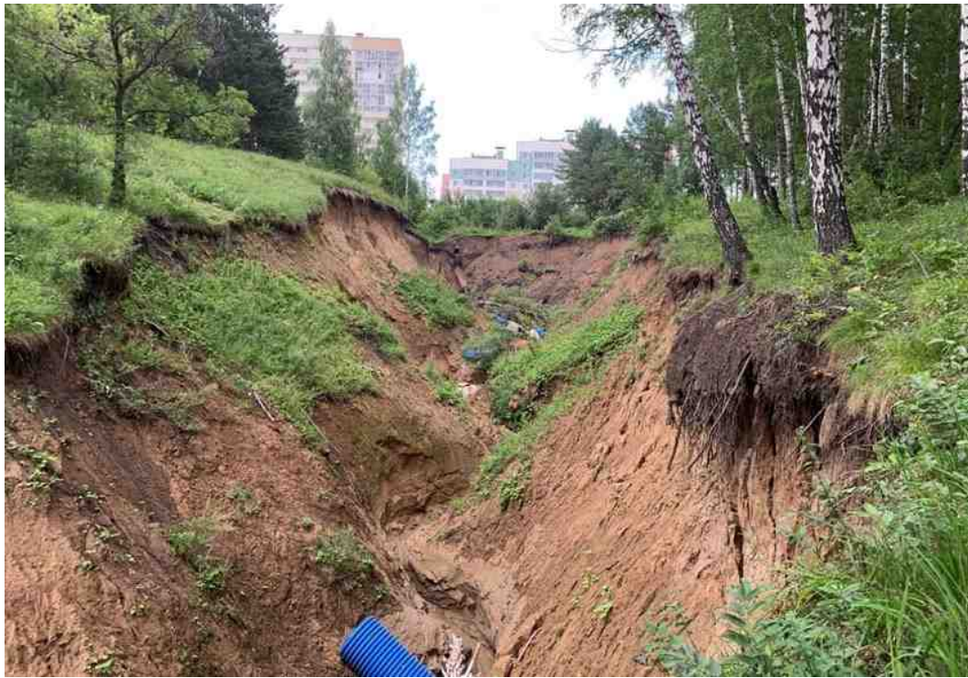
Рис. 2.38 Овражная эрозия в мкр Серебряный Бор, г. Кемерово, Кемеровская область-Кузбасс
