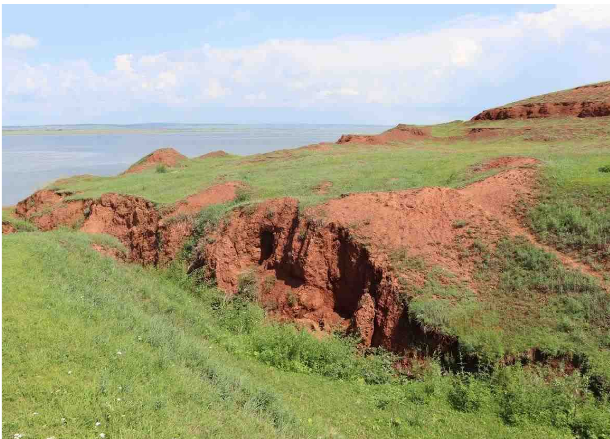
Рис. 2.37 Развитие овражной эрозии на берегу Братского водохранилища, вблизи с. Нукуты, Иркутская область
