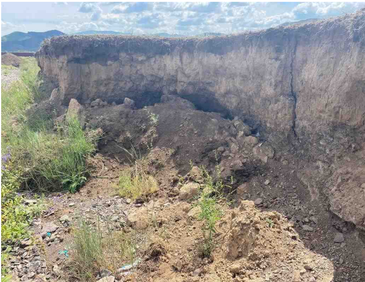
Рис. 2.22 Разрушение бортов оврага на пункте Уюкский в районе с. Уюк Пий-Хемского района, Республика Тыва
