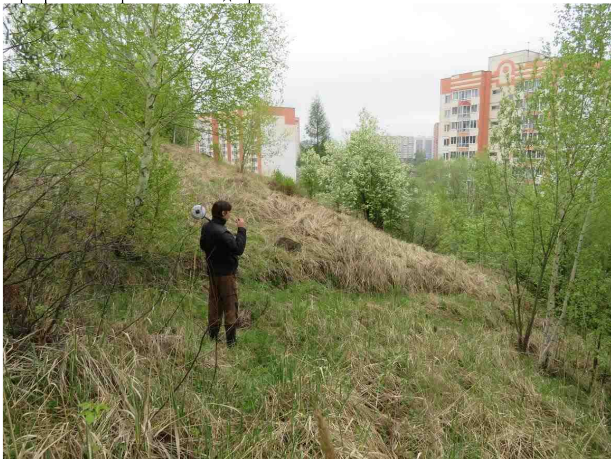
Рис. 2.45 Оползневые процессы на пункте наблюдений мкр. Солнечный в г. Томске, Томская область
