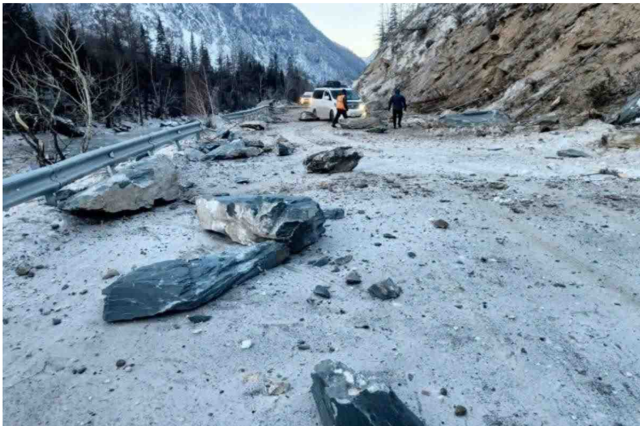
Рис. 2.20 Обвалившиеся глыбы на участке автодороги Р-256 (764-765км), Республика Алтай (Фото из СМИ [13])
