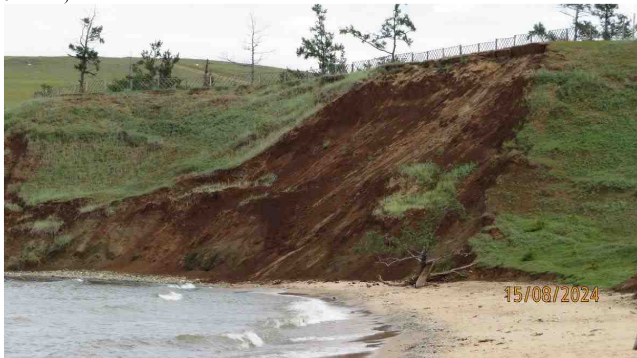
Рис. 2.39 Оползневые процессы на пункте наблюдений Сарайский, о. Ольхон, Иркутская область
