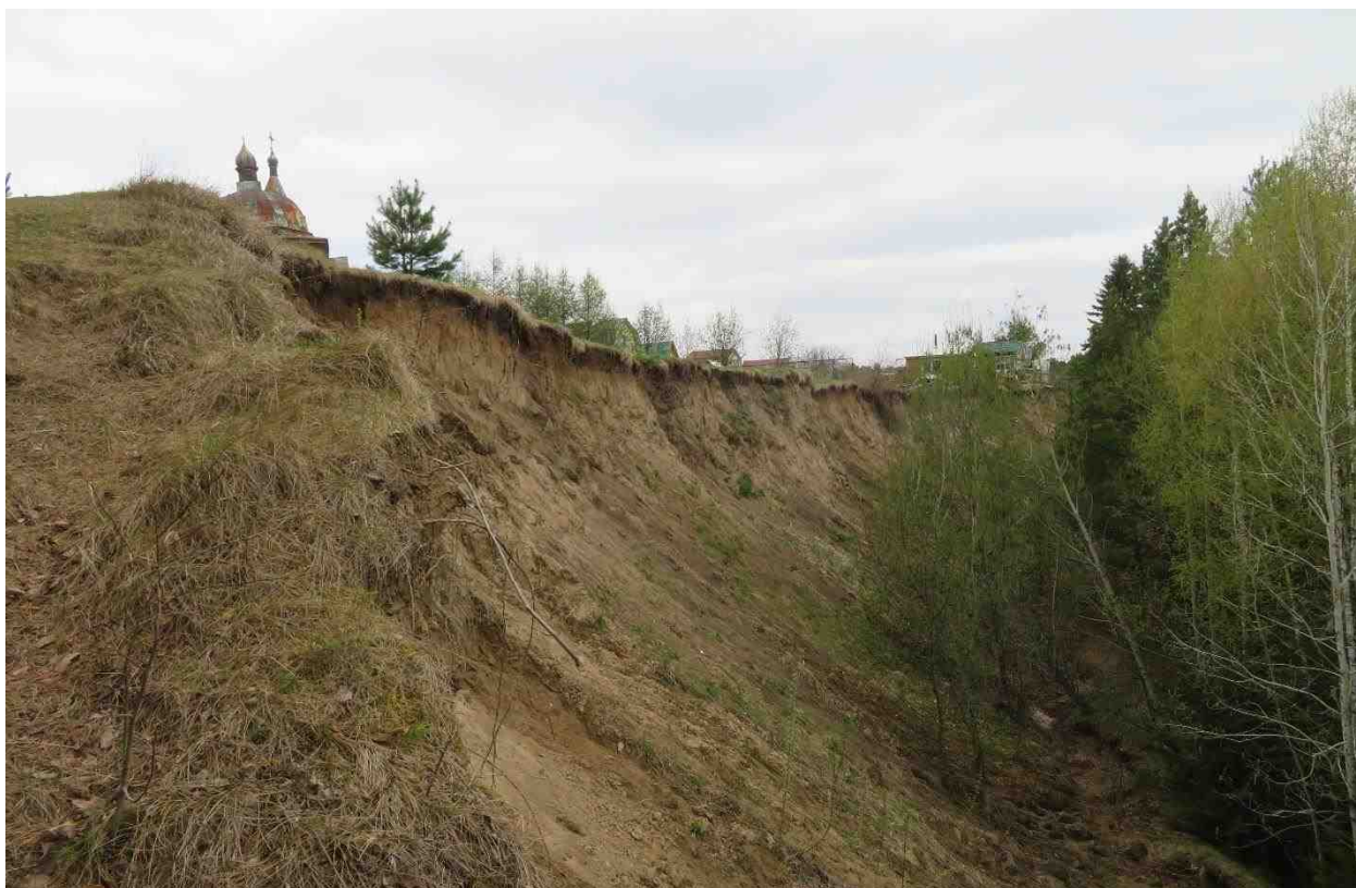
Рис. 2.46 Стенка отрыва оползня в д. Нагорный Иштан, Томская область
