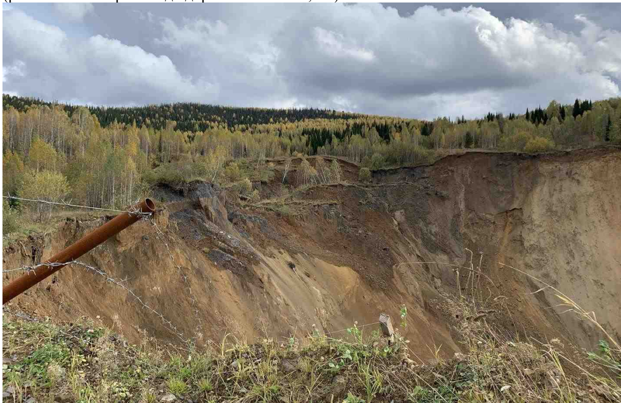
Рис. 2.41 Активизировавшийся провал в пгт Шерегеш, Таштагольский район, Кемеровская область-Кузбасс
