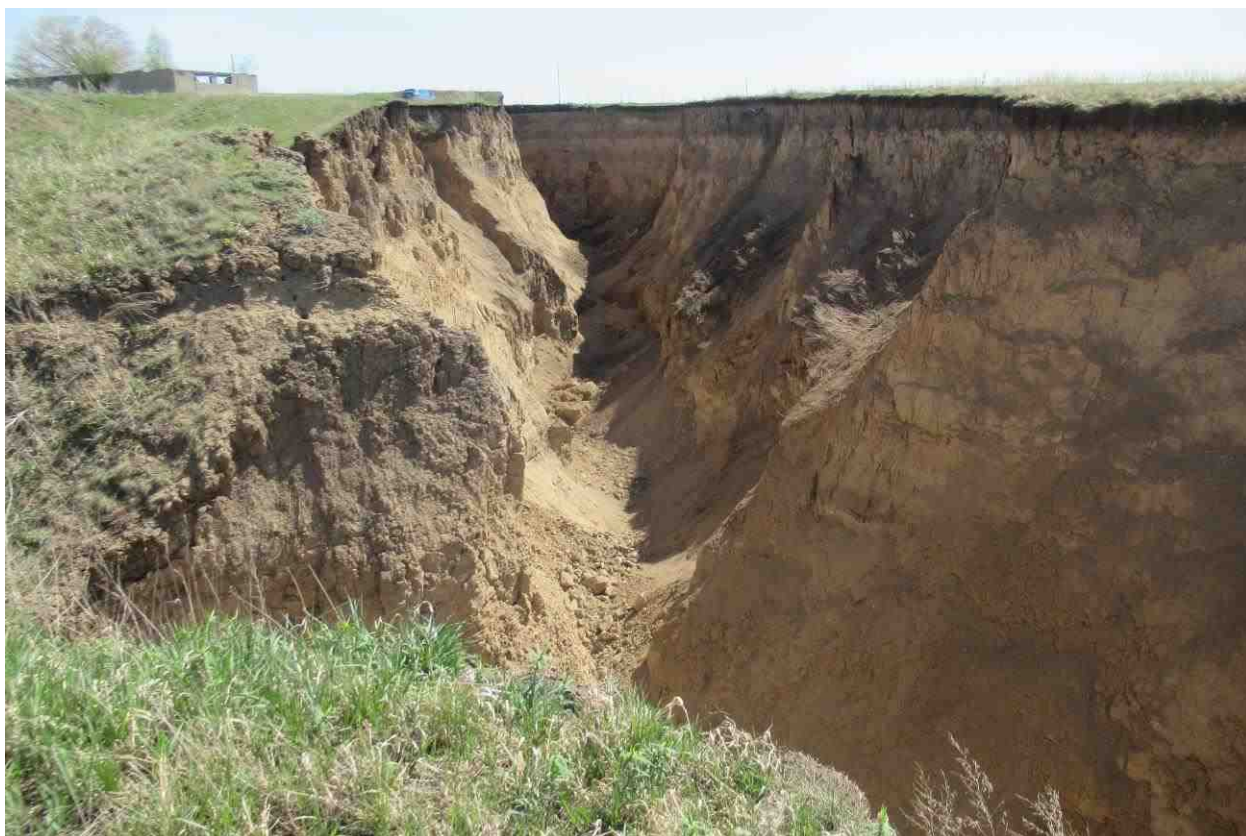
Рис. 2.28 Вершина растущего оврага № 1 в с. Чернопятово Павловского района, Алтайский край
