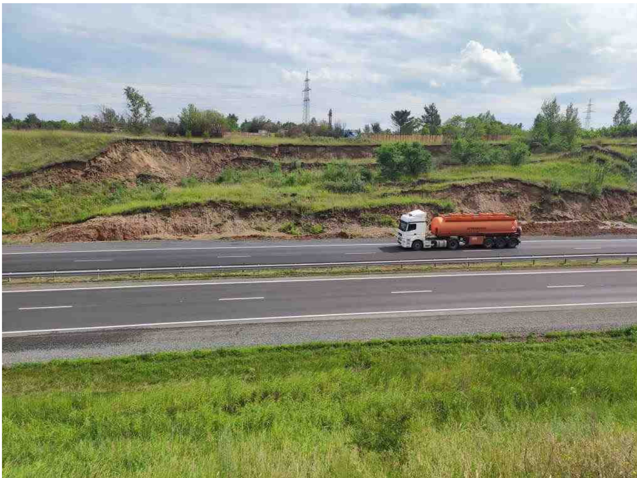
Рис. 2.25 Оползневые процессы на участке автодороги Р-257 Братский мост, Алтайский район, Республика Хакасия
