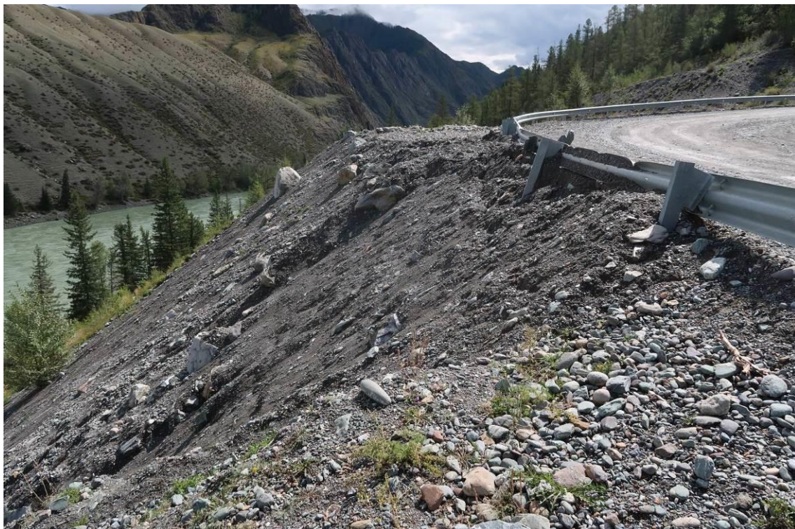
Фото 04-12-00020. Разрушение отбойников и откосов автодороги осыпным процессом на автодороге в с. Инегень, Онгудайский район, Республика Алтай, 20.08.2025
