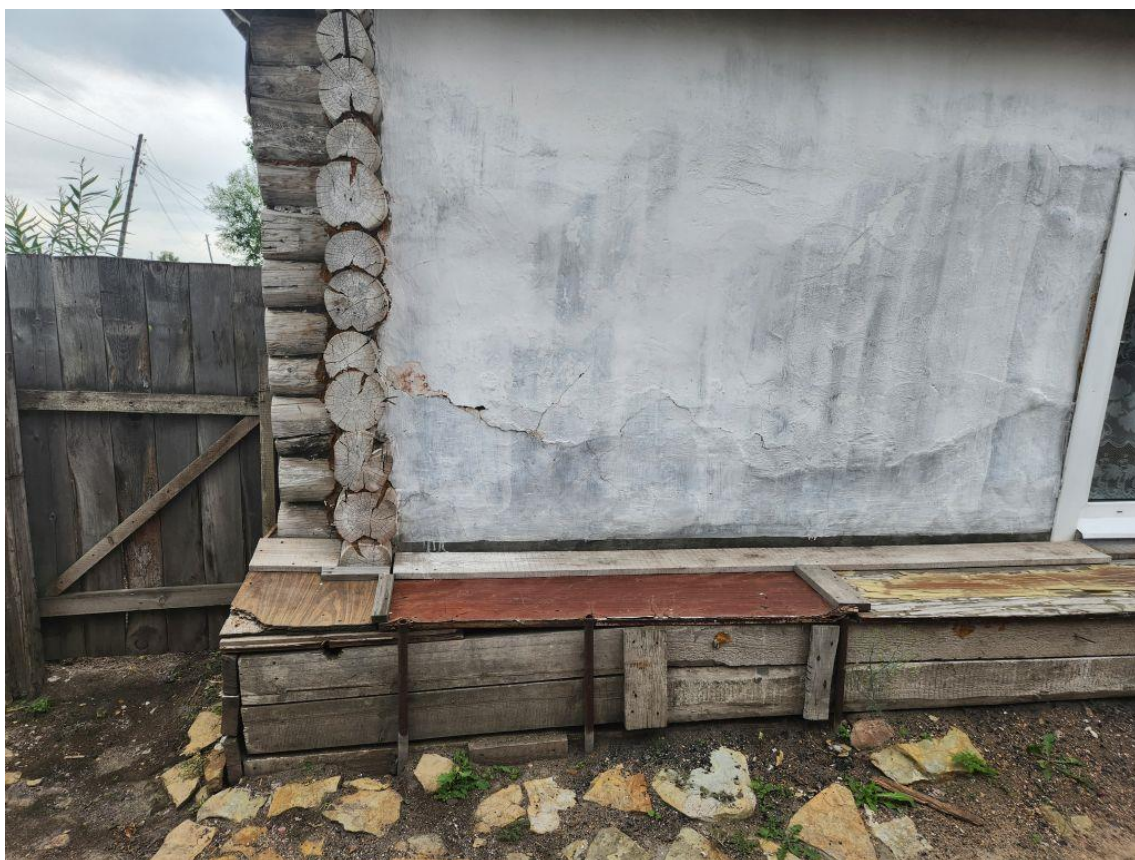
Фото 19-13-00013. Разрушение стены дома по ул. Лазо, с. Шира, Ширинский район, Республика Хакасия, 28.07.2025
