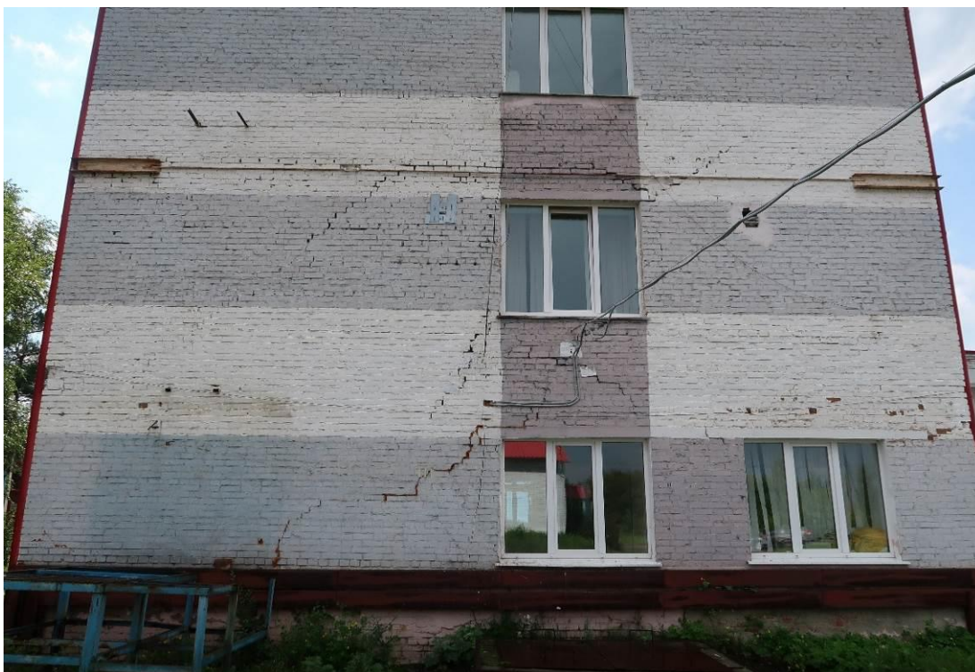
Фото 42-13-00007. Деформация центрального здания больницы, на трещины установлены маячки, пгт. Яя, Яйский округ, Кемеровская область-Кузбасс, 14.08.2025
