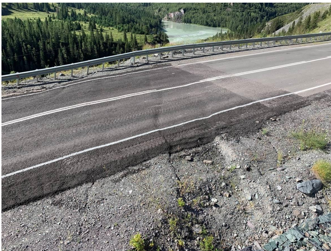
Фото 04-11-00057. Деформации дорожного полотна автодороги в Алтайское подворье, 20,05 км, Онгудайский район, Республика Алтай, 24.07.2025
