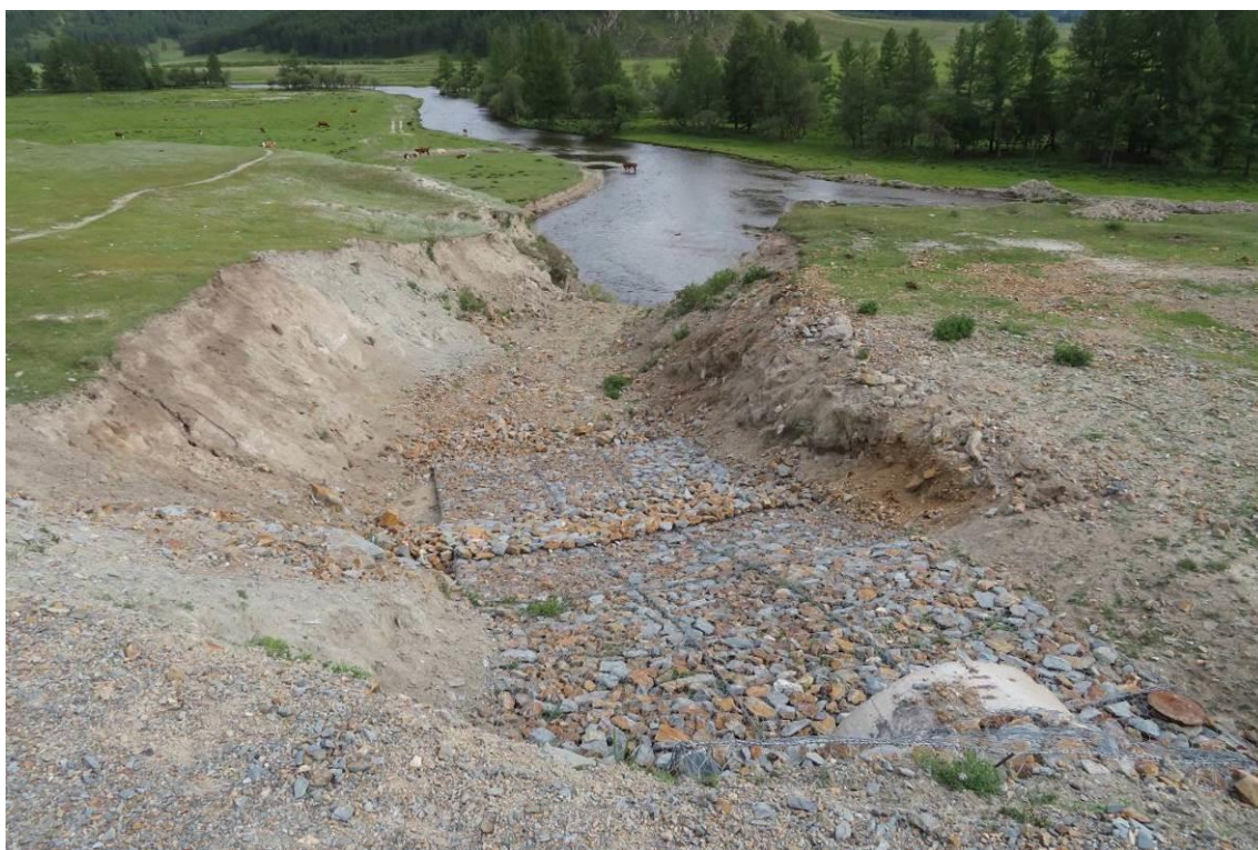
Фото 04-22-00009. В овраге № 4 в 2025 г. выположены борта оврага, габионами выложено днище, укреплен водовыпуск и вершина оврага (уч. а/дороги Туекта – Усть-Кан, 19,96 км), с. Кара-Кобы, Онгудайский район, Республика Алтай, 25.07.2025
