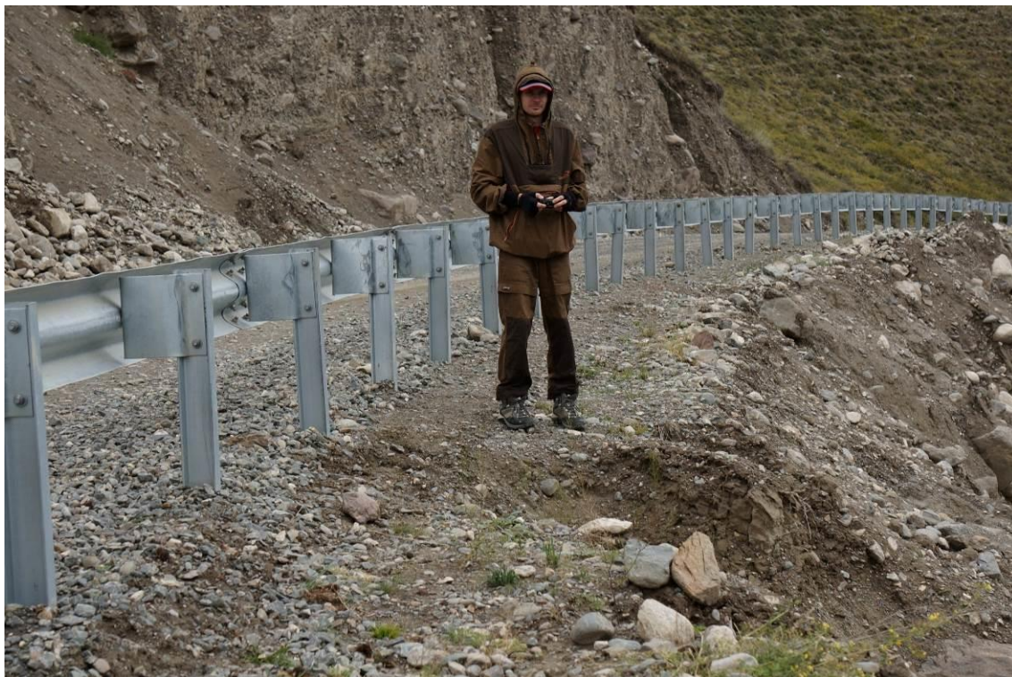
Фото 04-12-00017. Осыпание рыхлого материала и развитие промоин в уступе склона, автодорога Кош-Агач – Джазатор, 101,2 км, Кош-Агачский район, Республика Алтай, 13.08.2025
