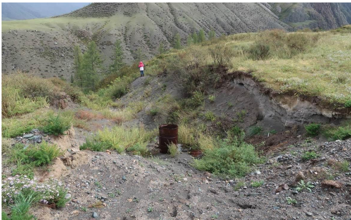
Фото 04-22-00012. Овраг по техногенной расчистке вспомогательной дороги, автодорога в с. Инегень, Онгудайский район, Республика Алтай, 20.08.2025
