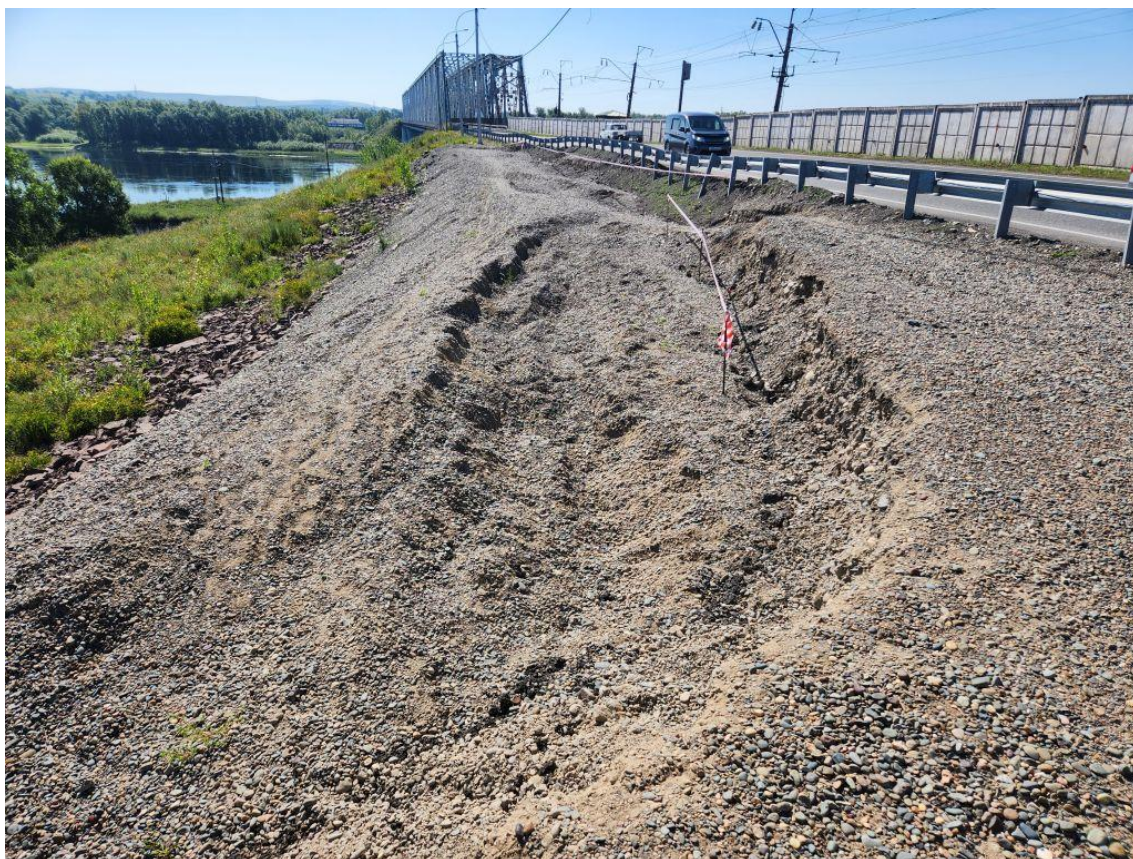
Фото 19-11-00008. Оползание обочины на уч. а/дороги Абакан – Подсинее, 7,15-7,25 км, Алтайский район, Республика Хакасия, 27.07.2025
