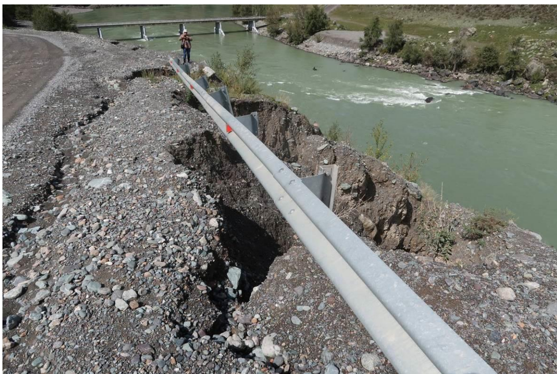
Фото 04-22-00011. Разрушение дорожного полотна, отбойников и откосов дороги в вершине оврага, автодорога в с. Инегень, Онгудайский район, Республика Алтай, 20.08.2025
