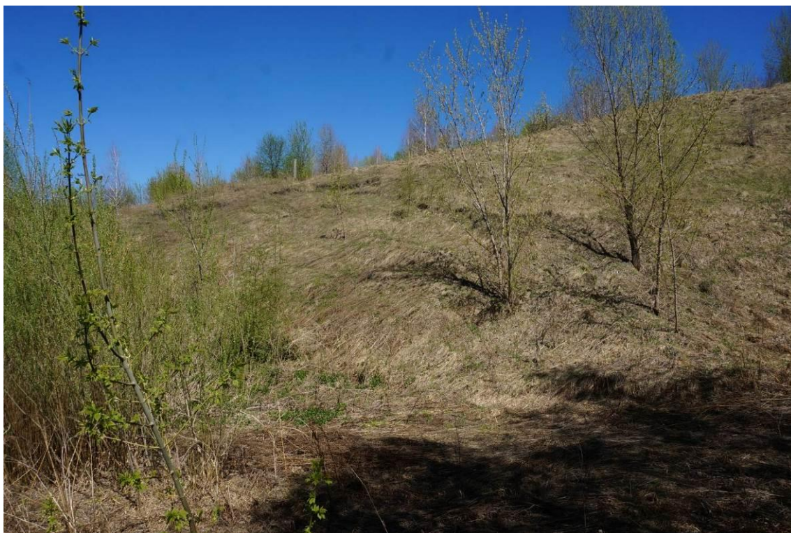
Фото 04-11-00002. Оползень II порядка, в подошве языка столб ЛЭП, с. Майма, Майминский район, Республика Алтай, 29.04.2026
