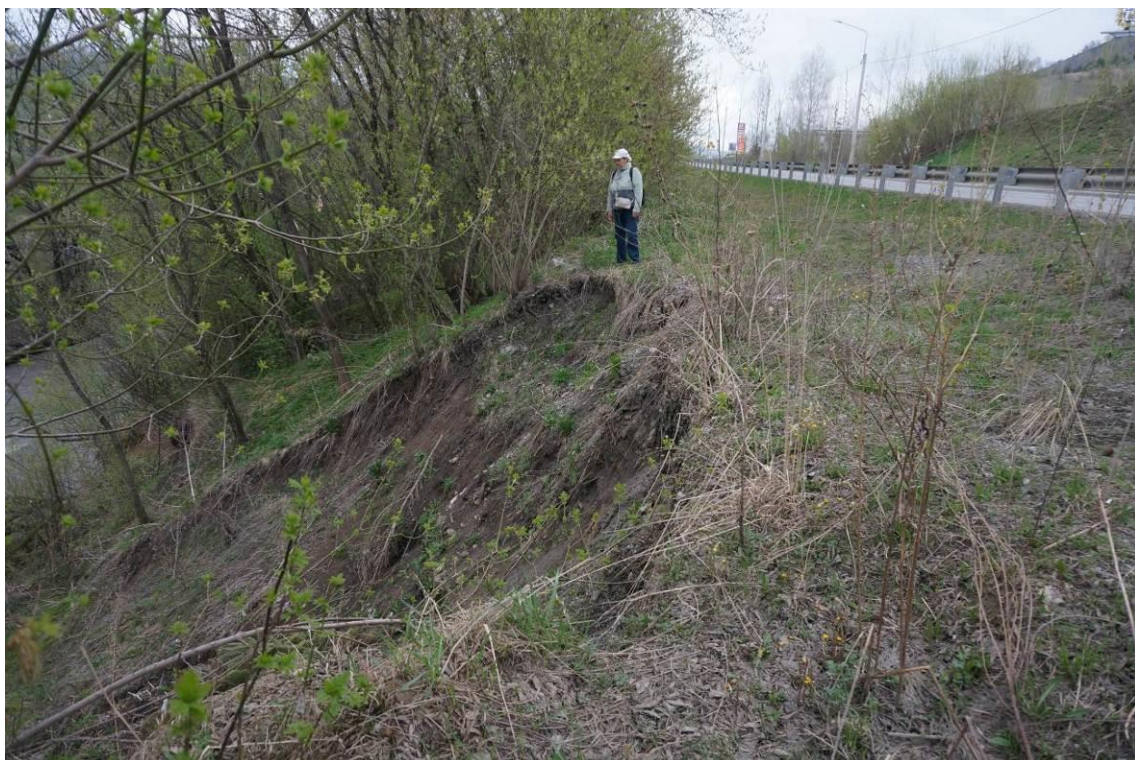
Фото 04-11-00066. Надоползневый уступ в 5,5-6,3 м от отбойников автодороги, автодорога Горно-Алтайск – Кызыл-Озек, 0,11 км, Майминский район, Республика Алтай, 27.04.2026
