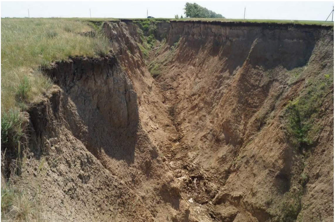
Фото 22-22-00041. Овражная эрозия на пункте Красноярский, овраг № 3, в окрестностях с. Красноярка, Топчихинский район, Алтайский край, 07.06.2026
