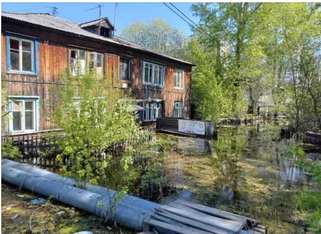
Фото 70-13-00002. Подтопление жилой застройки, г. Томск, мкр. Черемошники, Томская область, 26.05.2026
