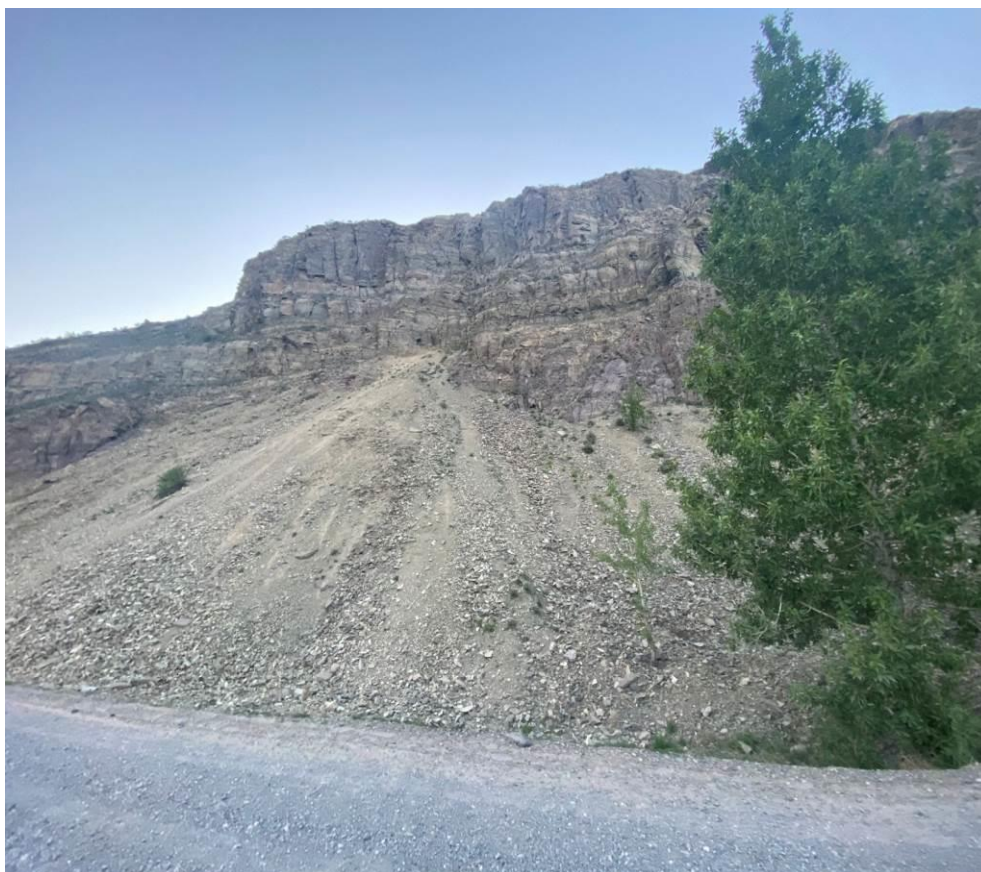
Фото 17-12-00002. Осыпной склон с подвижной осыпью, уч. а/дороги Кызыл – Баян-Кол, 23-24 км, Кызылский район, Республика Тыва, 05.06.2026
