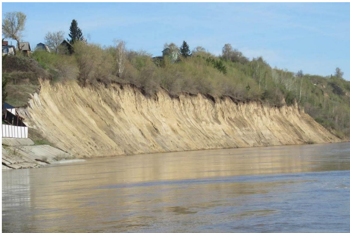
Фото 22-11-00043. Эрозионный оползень на левом береговом склоне долины р. Обь напротив СНТ «Энергетик», г. Барнаул, Алтайский край, 01.05.2026
