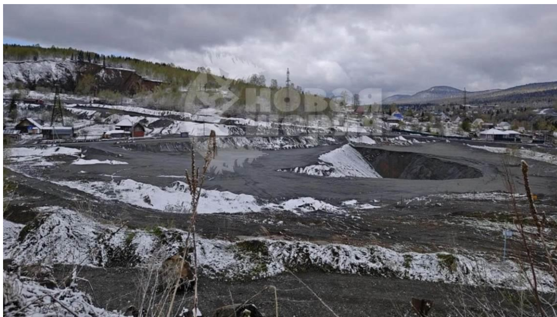
Фото 42-26-00002. Общий вид на провал в сторону ул. Первомайская и ул. Веры Волошиной, пгт. Шерегеш, Таштагольский округ, Кемеровская область-Кузбасс, 23.04.2026 ( https://vk.com/shorianews )
